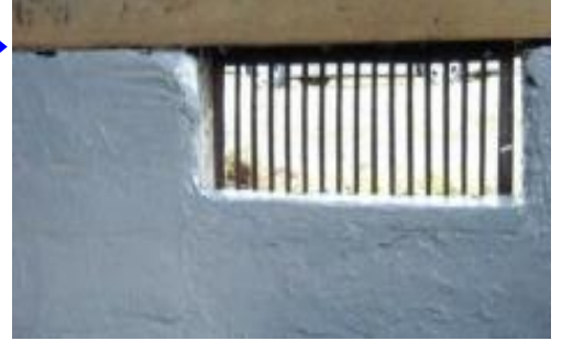
パワーアラスト塗布後のコンクリート基礎
